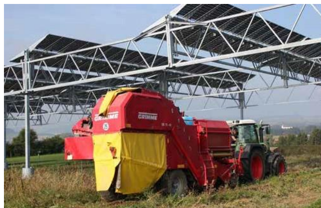
図 34: ポテトハーベスターでモジュールの下を耕すことができる、高い取り付け構造を持つシステム。
