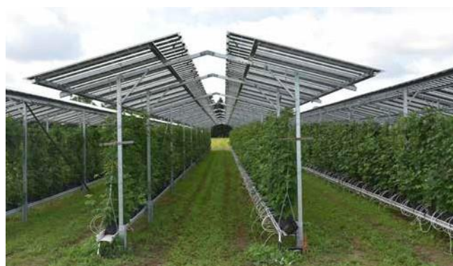
図 33: 空間的に分割された太陽電池とプロテクティブ機能を持つPVモジュール（オランダ）。© BayWa r.e.
