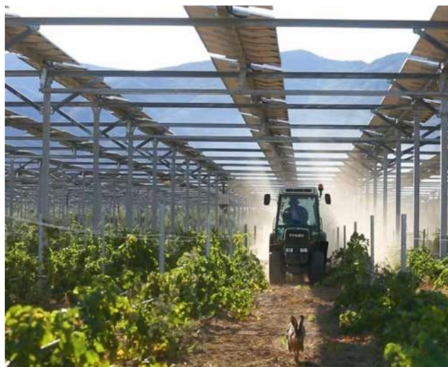
図 40: 高い架台と連続したPVモジュールの列を持つシステム。© Sun'Agri
