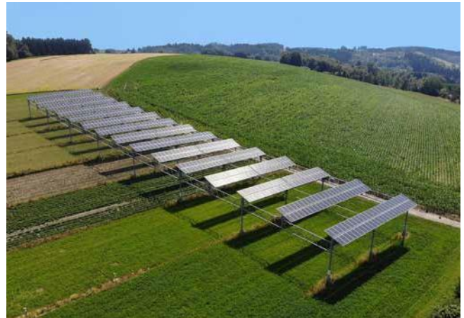
図46:194kWpの容量を持つヘッゲルバッハの太陽光発電システム。 © BayWa r.e.
