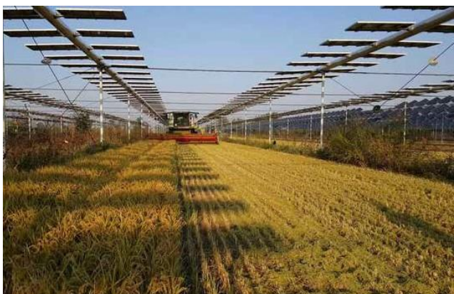
図 39: 高さのある架台と幅の狭い PV モジュールを組み合わせたシステム。© REM Tec
