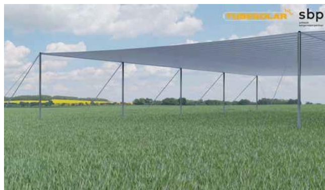
図38: TubeSolar 社によってテンションケーブルの間に設置されたチューブ型太陽電池モジュールによる半日陰。© SBP SONNE GMBH
