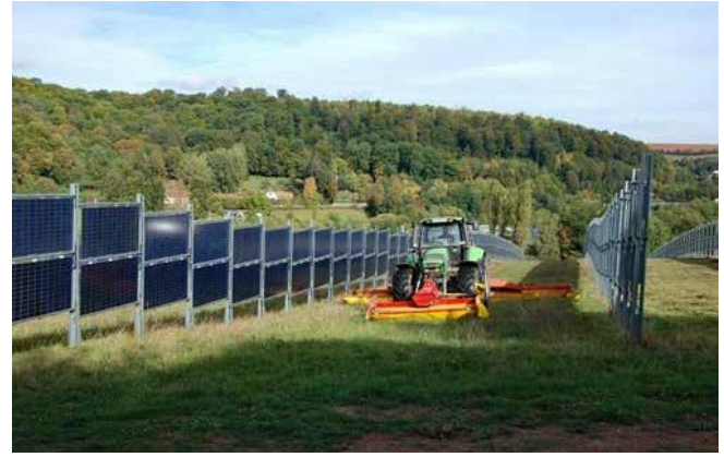
図 27:Next2Sun GmbHが建設したEppelborn- Dirmingen ソーラーパーク（ザールラント州、容量2MWp）の垂直配向型バイフェイシャルモジュール。© Next2Sun GmbH
