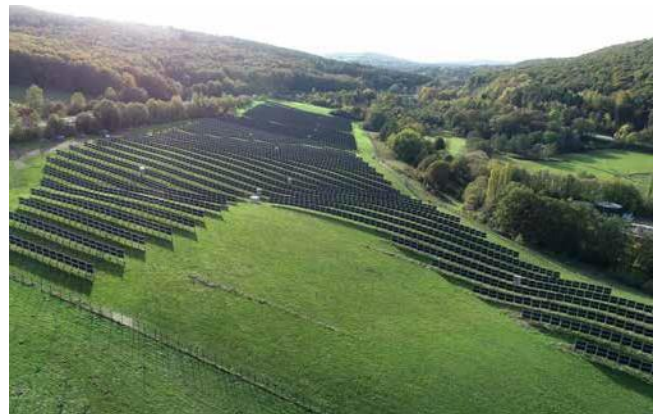
図47 : Next2Sunによる縦型PVモジュールを搭載した2MWpの Solarpark Eppelborn-Dirmingen。© Next2Sun GmbH
