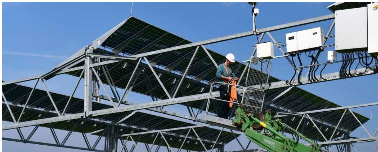
図 49: ヘッゲルバッハのアグリボルタシステムのメンテナンス作業。
