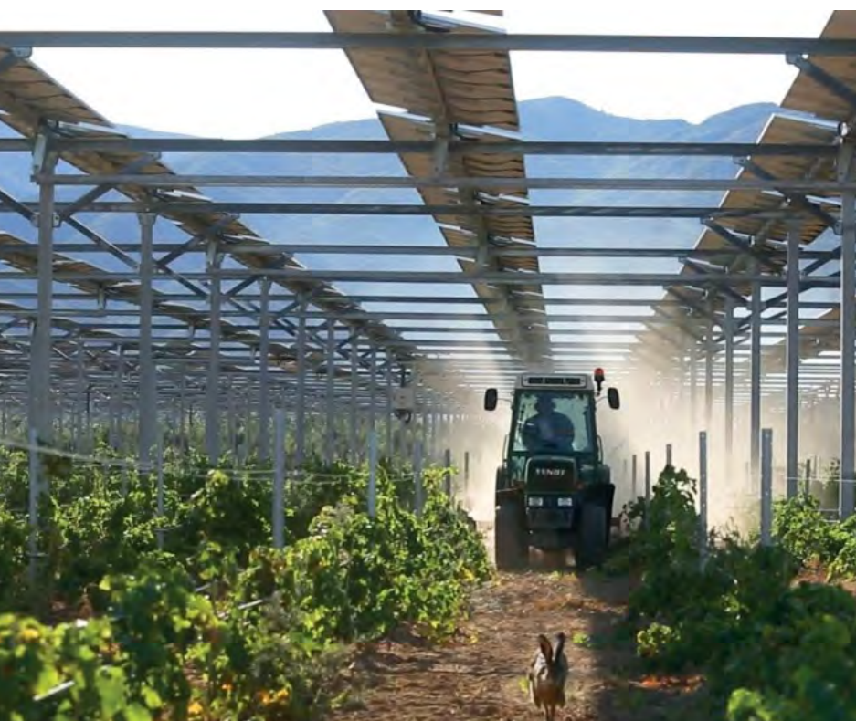
Abb. 58: Hoch aufgeständerte Anlage mit durchgängigen Modulreihen © Sun'Agri
