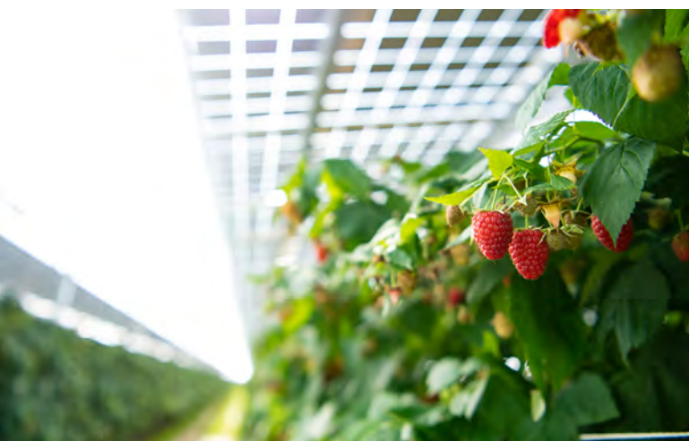
Abb. 41: Witterungsschutz für Himbeeren durch Agri-PV. 300 kW p Testanlage von BayWa r.e. in den Niederlanden © BayWa r.e.
