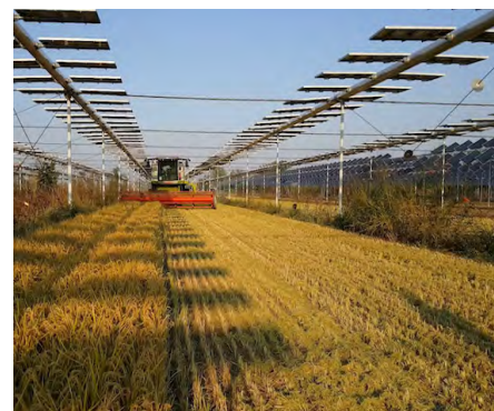
Abb. 57: Hoch aufgeständerte Anlagen mit schmalen PV-Modulen in Italien © REM Tec
