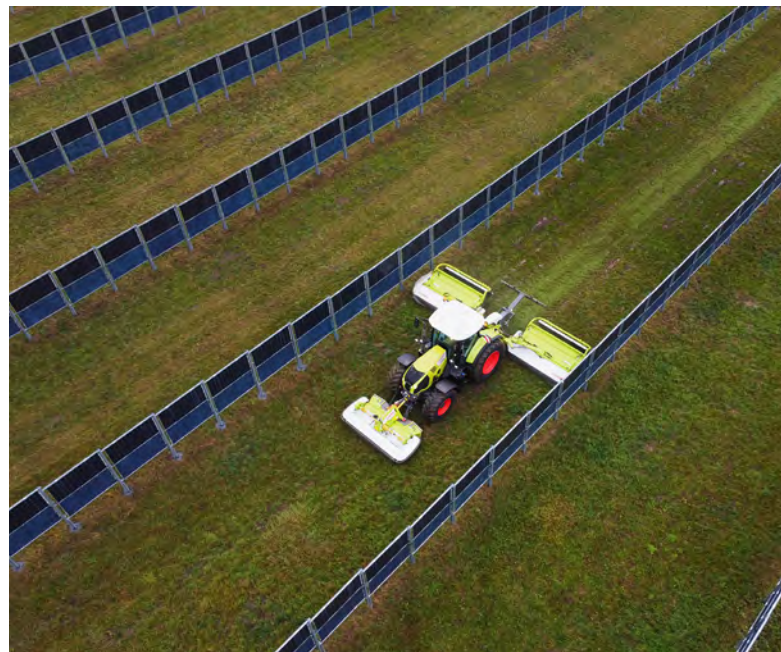
Abb. 25: Vertikale Agri-PV in Aasen, Donaueschingen © Solverde Bürgerkraftwerke
