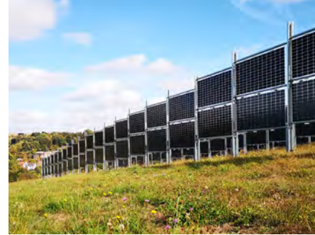
Abb. 53: Bifaziale, senkrecht aufgestellte Module von Next2Sun, Eppelborn-Dirmingen © Next2Sun GmbH
