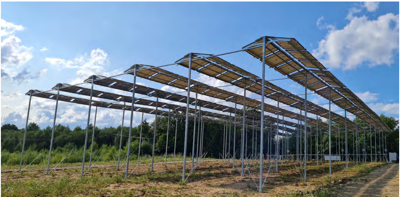
Abb. 22: Hochaufgeständerte Agri-PV-Anlage über einer Wiederaufforstungsfläche
