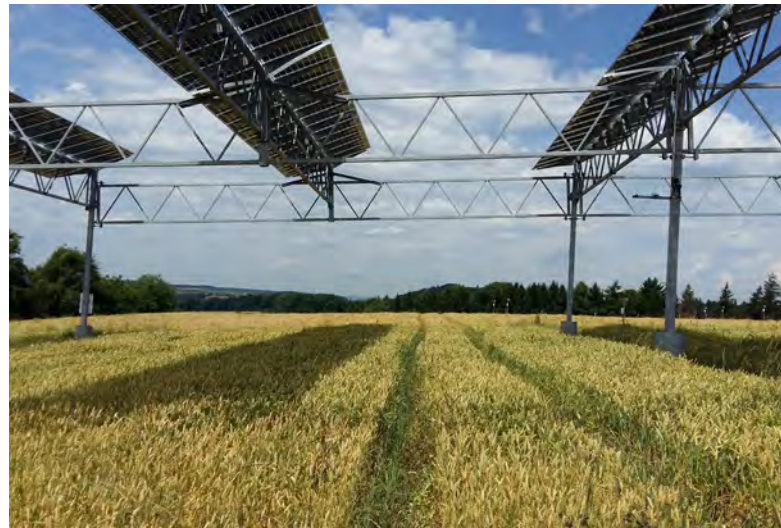
Abb. 62: Die Schattenstreifen der PV-Module wandern mit dem Sonnenstand © Universität Hohenheim
