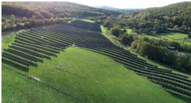
Abb. 66: Solarpark Eppelborn-Dirmingen mit 2 MW p mit vertikalen Solarzäunen von Next2Sun © Next2Sun GmbH
