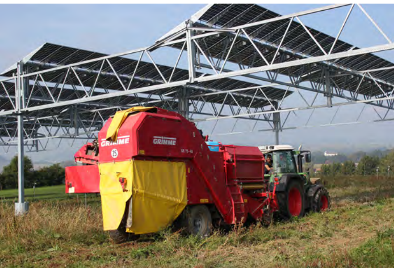
Abb. 51: Hoch aufgeständerte Anlage mit Möglichkeit zur Bewirtschaftung mit dem Kartoffelvollernter © Hofgemeinschaft Heggbach
