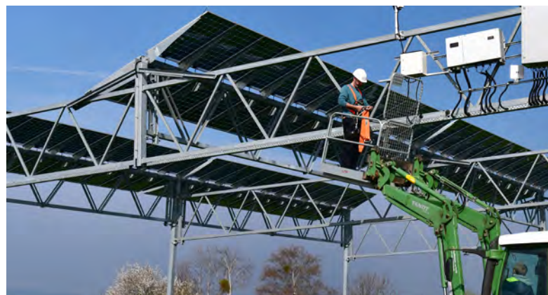
Abb. 69: Wartungsarbeiten an der Agri-PV-Anlage in Heggelbach © Fraunhofer ISE
