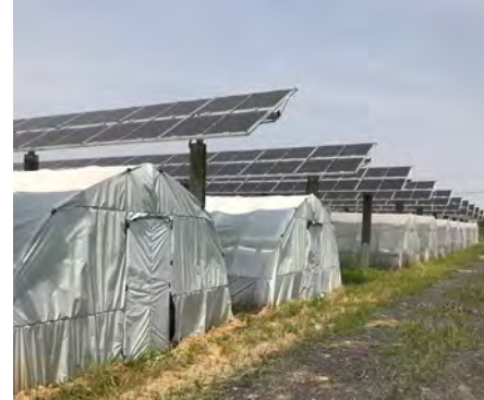
Abb. 54: PV-Module über einem Folientunnel © BayWa r.e.
