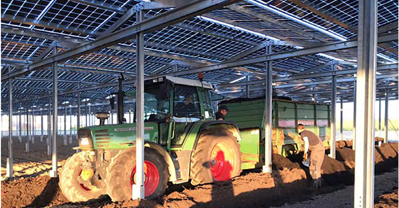
Abb. 67: Arbeiten in einer Agri-PV-Anlage unter den PV-Modulen © Fabian Karthaus
