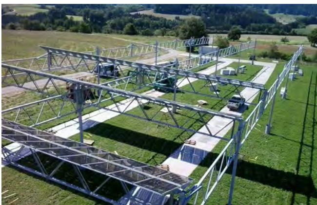
Abb. 68: Baustraßen zur Vermeidung von Bodenverdichtung © BayWa r.e
