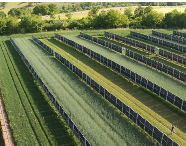
Abb. 29: Vertikale Agri-PV-Anlage in Merzig-Willingen, 2023 © Universität Hohenheim
