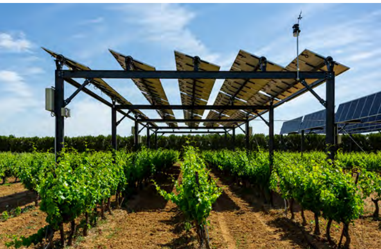
Abb. 40: Agri-PV mit nachgeführten Modulen in Frankreich © Sun'Agri
